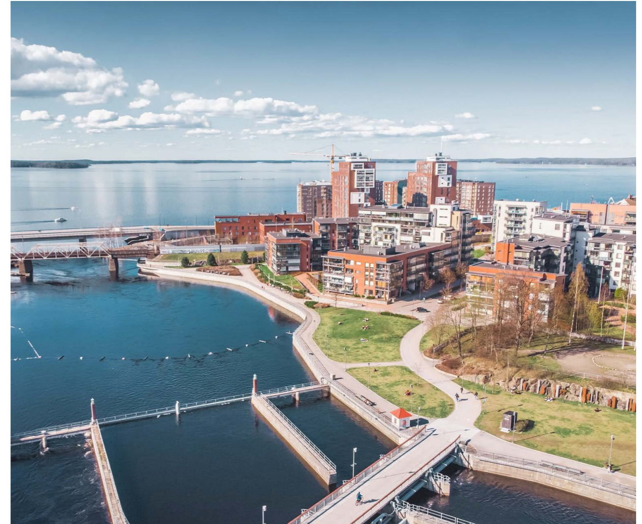
Kuva 38. Kasvava kaupunki rakentaa paljon niin asuntoja, palveluja kuin kaupunki-infraa. Tampere ottaa käyttöön hiilineutraaliuskriteerit koko maankäytön prosessissa, laskee rakentamisen hiilijalanjäljen ja minimoi sen mm. puurakentamisella, energiatehokkaalla rakentamisella ja hyödyntämällä mahdollisimman paljon uusiomateriaaleja. Kuva: Visit Tampere Oy / Laura Vanzo.
